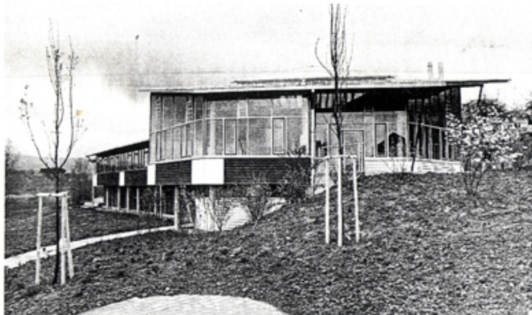
Die Grundschule in Oberweissach ist fertig. Vor vier Jahren hatte der Gemeinderat den Startschuss gegeben.
